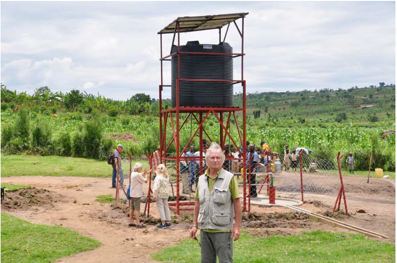
Municipale di Bioggio verifica sul posto l'impianto del pozzo
